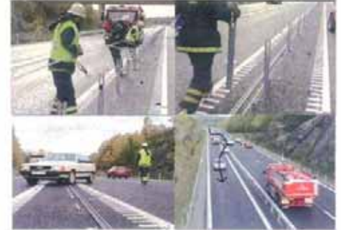
緊急時の解放 ワイヤーロープをポストから外し、ポストを引き抜く。ワイヤーロープの上を通過させ、交互通行により、交通を確保
