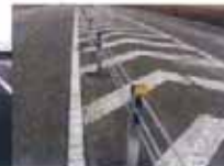
ガードケーブル(左)とワイヤーロープ式防護柵(右) 衝突時にたわむことで衝撃を吸収
