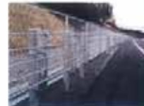
ガードケーブル(左)とワイヤーロープ式防護柵(右) 衝突時にたわむことで衝撃を吸収
