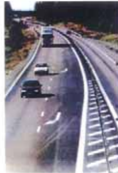
スウェーデンの2+1車線道路とワイヤーロープ式防護柵
